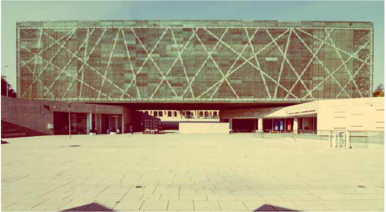
Las fachadas norte y sur del Museo de la Memoria están cubiertas por un revestimiento de cobre
