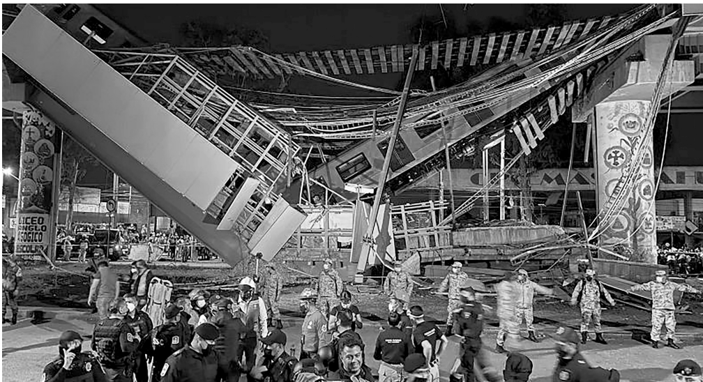
FIGURA 9. Colapso de vías de la línea 12 del metro de Ciudad de México. Fuente: Proceso (2021).
